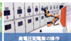
高電圧配電盤の操作
